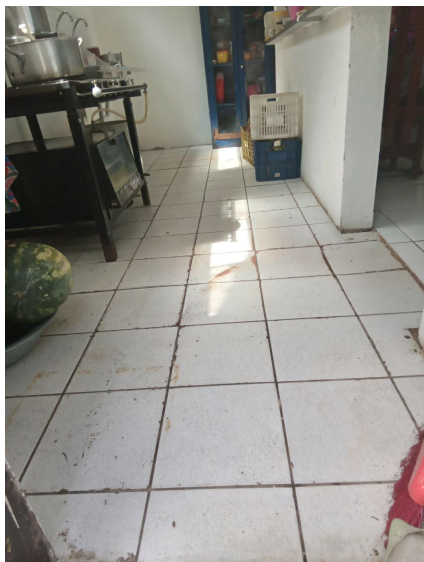
Piso da cozinha
